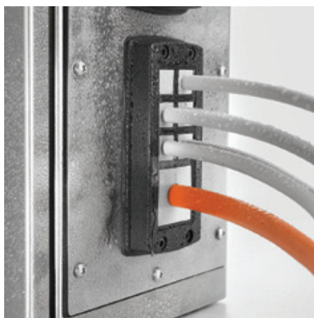
Figura 2. Alta confiabilidade: as vedações em espuma garantem uma elevada proteção IP e UL.
