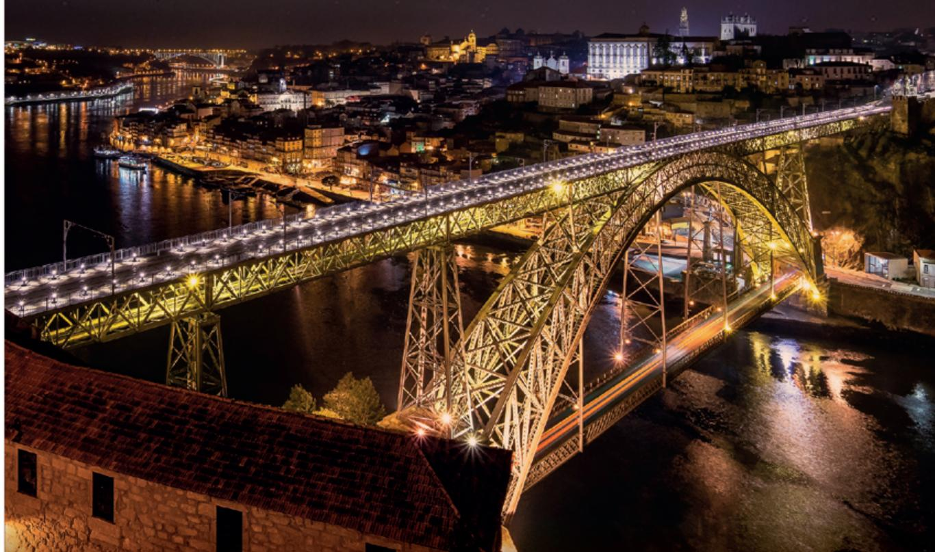
Uma adequação da tipologia da iluminação viária à arquitetura da ponte, com a passagem da utilização de luminária viárias de tecnologia de descarga para a utilização das tradicionais lanternas históricas, mas com tecnologia LED, com uma temperatura de cor de 2200K, por forma a manter o espírito antigo vivo, com uma boa eficiência.
